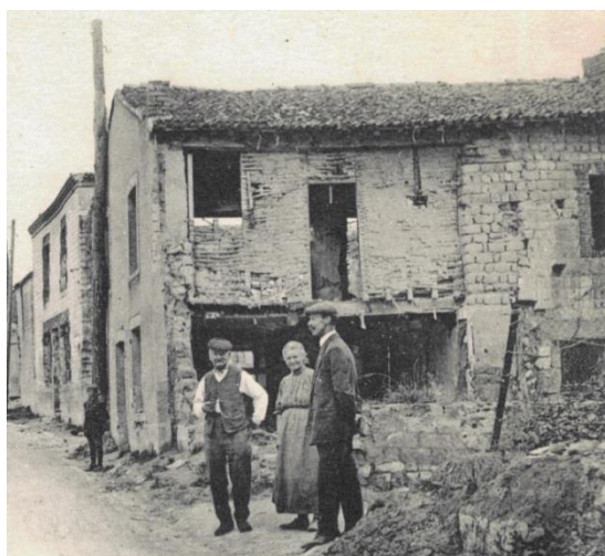
RUINE 1919 : Couverture en tuiles canal. En dessous : Reste de cloison en pans de bois et torchis sur lattis. A droite : Carreaux de terre.
